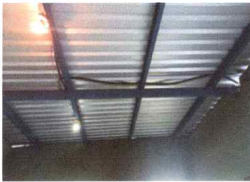
Cambio de techo en cocina
