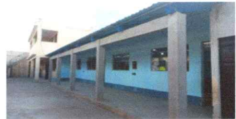
Sustitución de pilades y viga de madera en corredor
