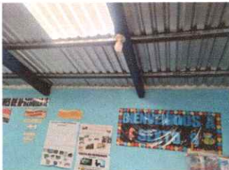
Nivelación de techo y solera bajo cubierta en aula 1 y 2 también cambio de costaneras de madera por costaneras galvanizadas.
