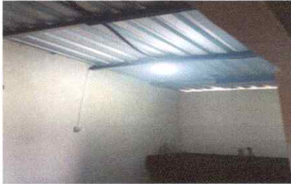
Instalación de sistema eléctrico en ampliación de cocina
